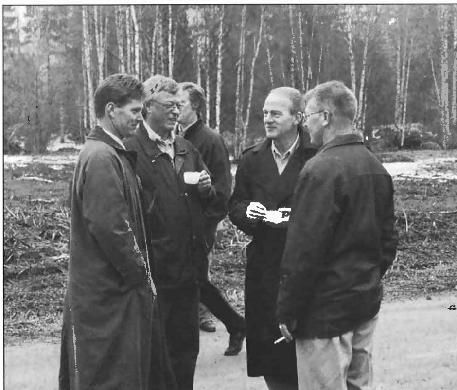
Planting av «grunnsten» ved byggestart på hangår OSL for Braathen.
